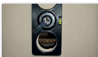
4 Befestigen der Bohrschablone mit dem Spanner.
