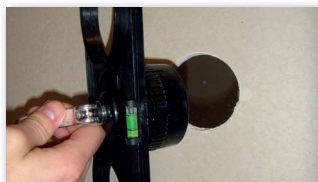
1 Bohren des mittleren Loches.
