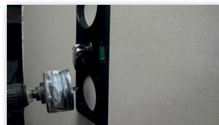
3 Anschließend durch die vorhandenen Locheinsätze bohren.
