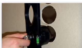
5 Einsetzen der Schablone.
