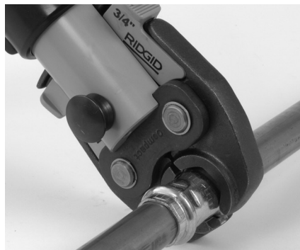
Slika 7 – Postavljanje makazastih čeljusti oko priključka
