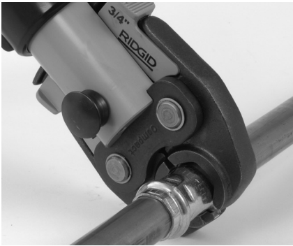
Figuur 7 – Aanbrengen van schaarbekken rond fitting
