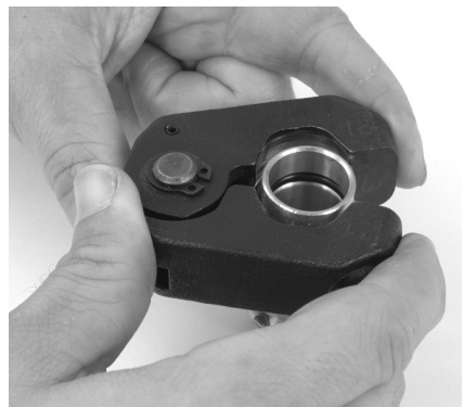
Slika 9 – Postavljanje prstenaste prese oko priključka
