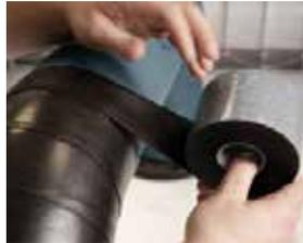
gewickelt. Das selbstverschweißende Material verbindet sich ohne weiteres Zutun mit der Oberfläche der Dämmung. Und das Beste daran: Es vulkanisiert nicht sofort, aber die Installation kann trotzdem innerhalb von 10 bis 20 Minuten nach dem Aufbringen angepasst werden. Ein Messer oder eine Schere ist alles, was Sie für die Installation benötigen.
