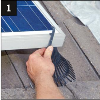
1 Befestigen Sie die vier mitgelieferten Winkelstücke mithilfe von zwei Montageklammern an den äußeren Ecken des Solarfeldes.
