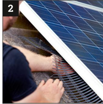
2 Beginnen Sie mit der Verlegung der 100 cm langen Vogelschutzelemente an einer Seite der Solarmodulfläche und kürzen Sie diese bei Bedarf auf die benötigte Länge ein.
