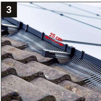
3 Platzieren Sie ca. alle 25 cm eine Montageklemme und befestigen Sie diese über den Arretiermechanismus am Modulrahmen.
