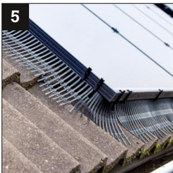
5 Wiederholen Sie diesen Vorgang an allen Seiten, sodass alle Solarmodule gemeinsam seitlich abgeschlossen werden und das Solarfeld gegen eindringende Tiere geschützt ist.
