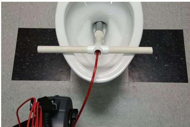
Abbildung 22 – Benutzung eines PVC Führungsrohrs
