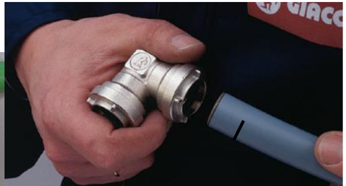
Einführen der Stützhülse
