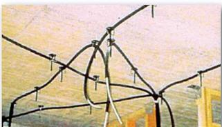
**8** Auch als Sammelhalter in abgehängten Decken verwendbar. Ohne Bohren, einfach kleben und fertig.
