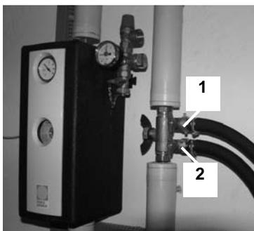
3. Brancher la conduite de refoulement (1) et la conduite circuit retour (2) sur l'ensemble de robinetterie KFE (vannes pour vidange et remplissage du circuit).
