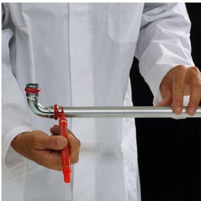
**Fig. 24** | Einsetzen der Rohre in die Fittings und Kennzeichnung
