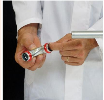
**Fig. 23** | Prüfung der Präsenz und der Positionierung der O-Ringe
