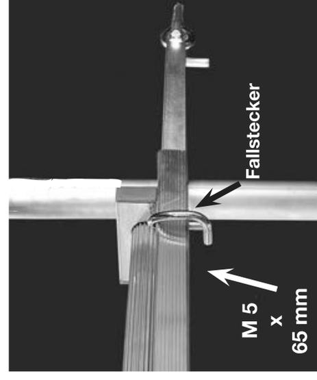
Hängen Sie das Stabilisierungsset in die Ringschraube an der Wand ein. Montieren Sie das Stabilisierungsset an der Sprosse unterhalb der obersten Belagbühne.
