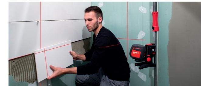
Der exakte 90°-Winkel erleichtert Ihnen Montagearbeiten, wie z. B. Vorhangschienen, Lichtspots oder Deckenverkleidungen.
